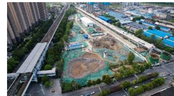
南泥湾大道南侧地块修复
